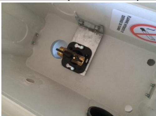
Закрепить кран на пластине с помощью винтов, входящих в комплект поставки.
